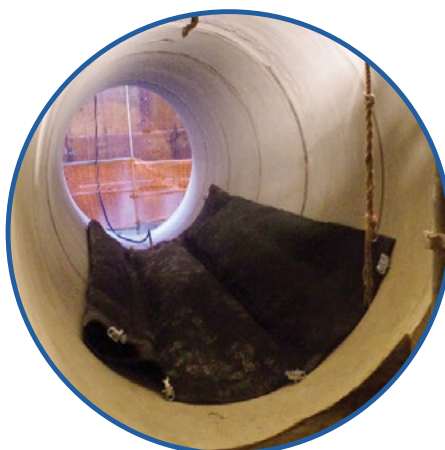
Ustawianie – korek w kształcie poduszki powinien być umieszczony horyzontalnie
